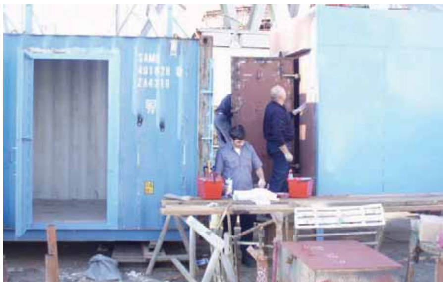
Završni radovi na izgradnji flashover simulatora
